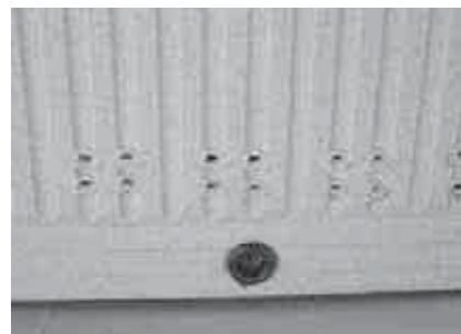
図24 側面に排水孔をあける
